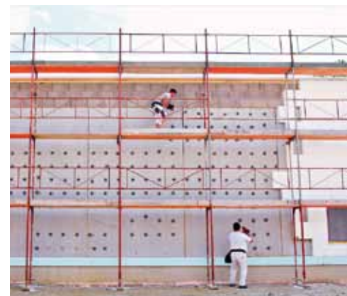
Kotvení izolačních desek
