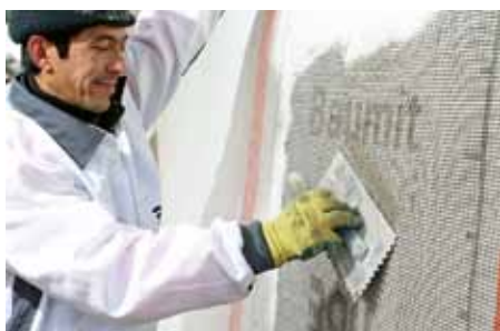
Vytváření výztužné vrstvy vložení sklotextilní síťoviny Baumit KeraTex
