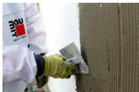
Nanášení stěrkové hmoty Baumit StarContact pro vytvoření výztužné vrstvy
