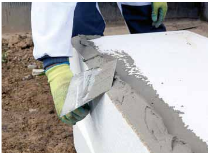
Nanášení lepicí hmoty Baumit StarContact formou rámečku a tří středových terčů s minimální plochou slepu 60 %
