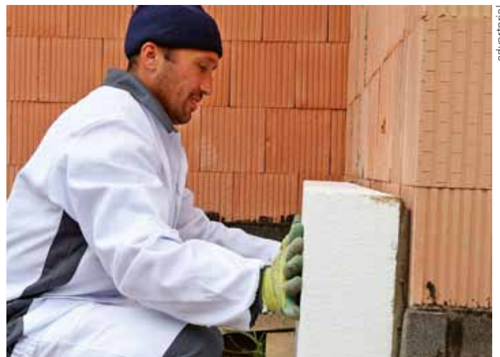
Lepení tepelněizolačních desek z EPS-F (minerální podklady není potřeba předem penetrovat)
