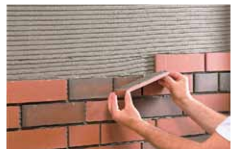
Baumit Ceramic – montáž obkladu
