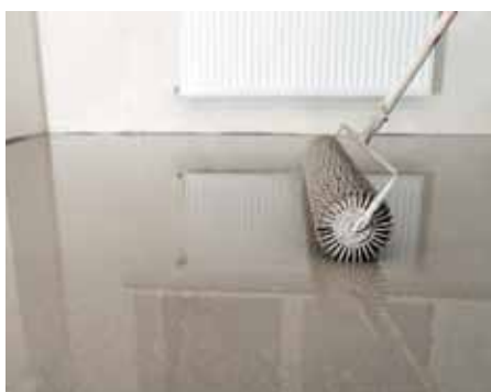
Provzdušnění čerstvě aplikované stěrky
