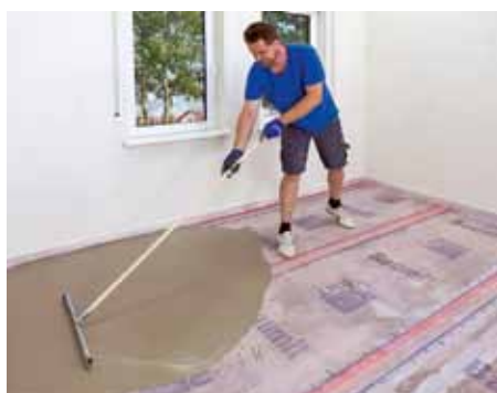
Aplikace stěrky v interiéru
