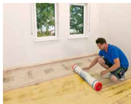
Vkládání sklotextilní síťoviny Baumit CeramicTex do skladby podlahy
