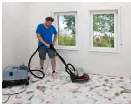
Broušení původní dřevěné podlahy
