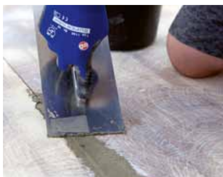
Spárování původní dřevěné podlahy cementovou maltou Baumit Baumacol Preciso
