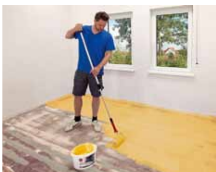
Aplikace kontaktního můstku Baumit SuperPrimer
