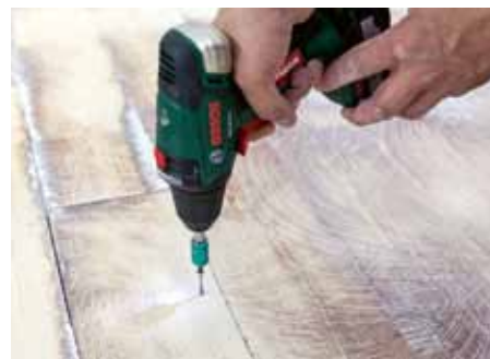
Fixace nestabilních prvků původní dřevěné podlahy
