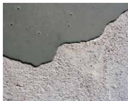
Detail vrstvy stěrky
