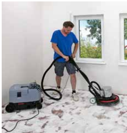
Broušení původní dřevěné podlahy
