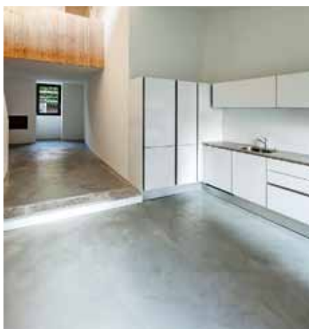
Finální realizace podlahy kuchyně
