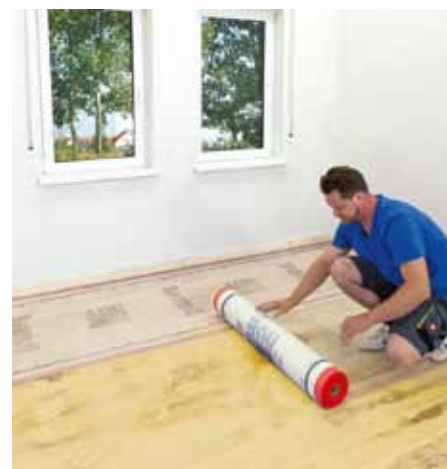
Vkládání sklotextilní síťoviny Baumit CeramicTex do skladby podlahy
