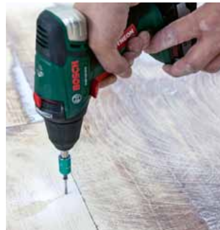
Fixace nestabilních prvků původní dřevěné podlahy
