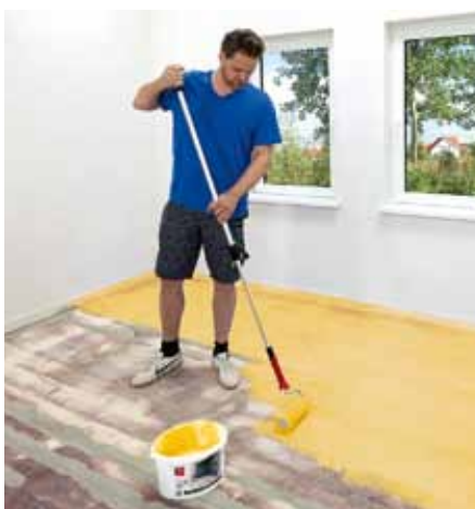
Aplikace kontaktního můstku Baumit SuperPrimer
