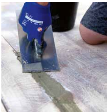
Spárování původní dřevěné podlahy cementovou maltou Baumit Baumacol Preciso
