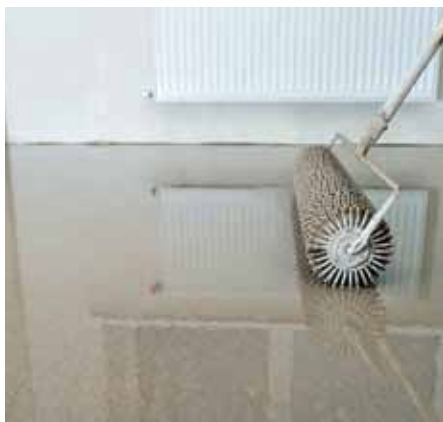
Provzdušnění čerstvě aplikované stěrky ježatým válečkem
