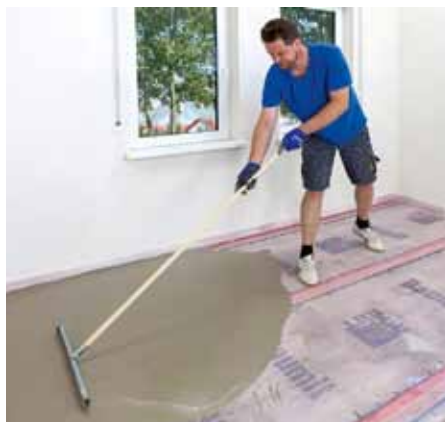
Aplikace stěrky v interiéru
