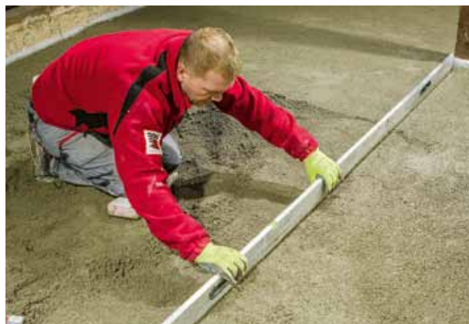
Baumit PorBeton – vyrovnání povrchu
