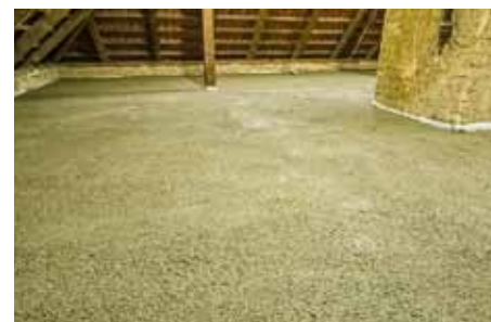
Baumit PorBeton – zhotovený potěr
