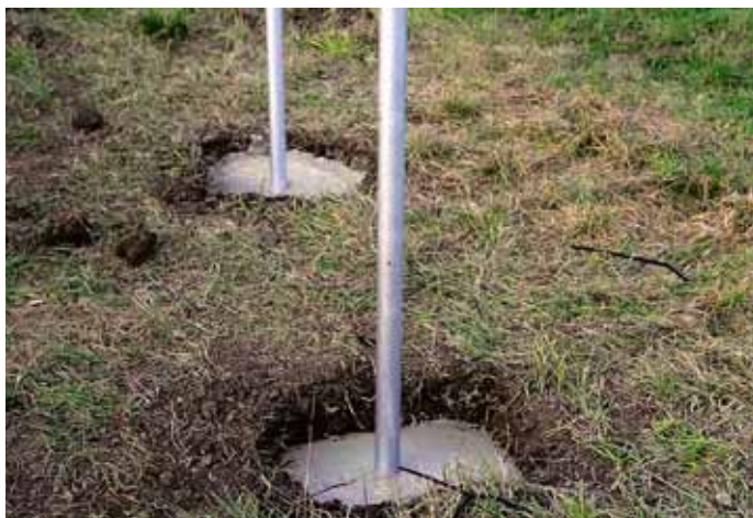
Baumit FixBeton – zhotovené základové patky sloupků
