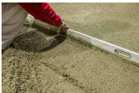
Baumit PorBeton – finální úprava povrchu
