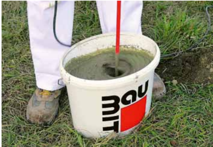
Baumit FixBeton – 1. způsob aplikace – strojní míchání směsi
