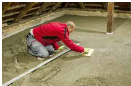
Baumit PorBeton – zahlazení povrchu
