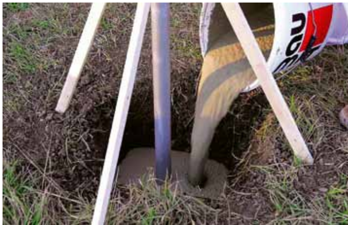
Baumit FixBeton – betonáž základové patky
