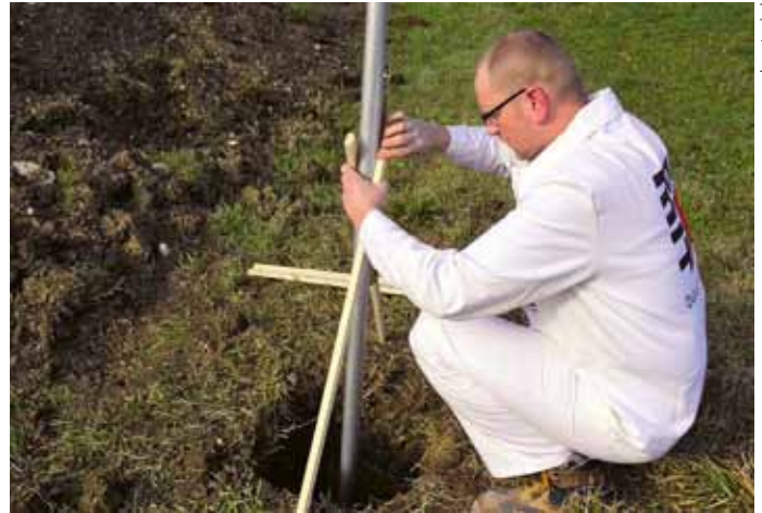
Baumit FixBeton – příprava betonáže
