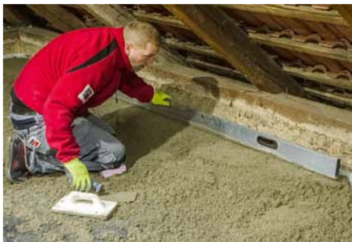
Baumit PorBeton – příprava stahovacích pruhů
