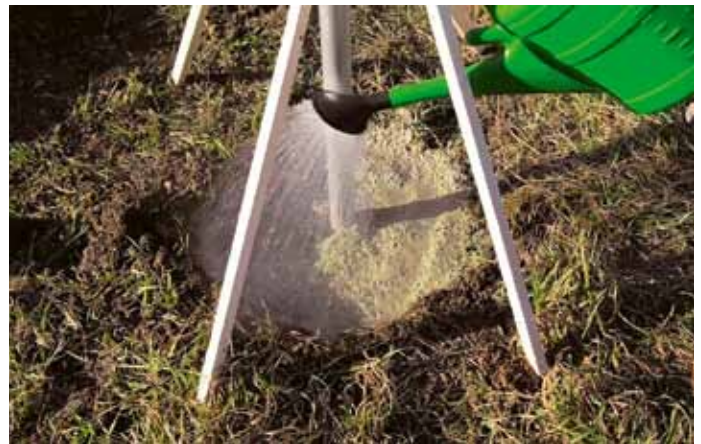
Baumit FixBeton – 2. způsob aplikace – zalití suché směsi
