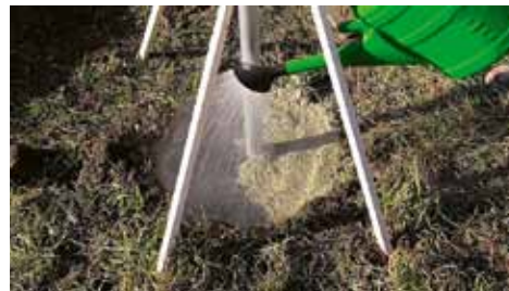
Baumit FixBeton – zalití suché směsí
