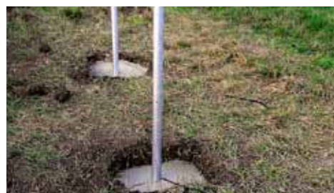
Baumit FixBeton – zhotovené základové patky sloupků
