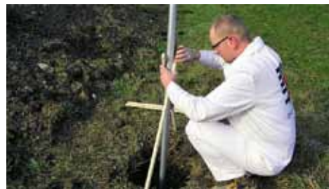
Baumit FixBeton – příprava betonáže
