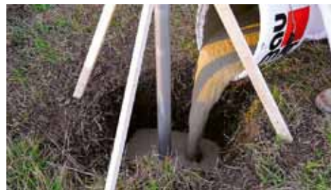
Baumit FixBeton – betonáž základové patky
