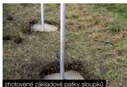
zhotovené základové patky sloupků
