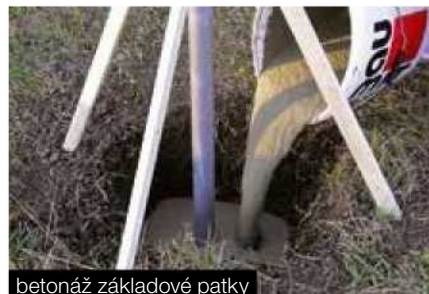
betonáž základové patky
