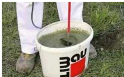
1. způsob aplikace – strojní míchání směsi
