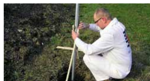
Baumit FixBeton – příprava betonáže
