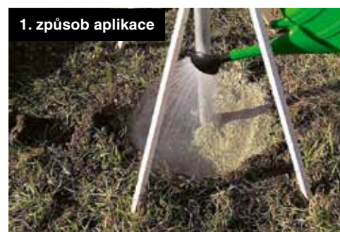
Baumit FixBeton – zalít suché směsí
