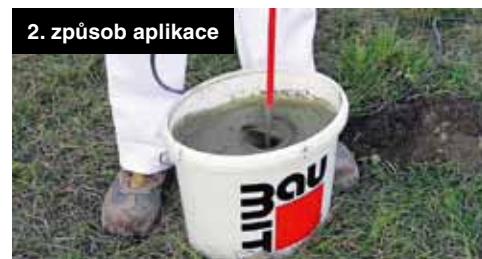
Baumit FixBeton – strojní míchání směsi
