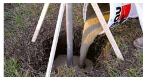
Baumit FixBeton – betonáž základové patky
