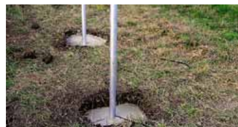
Baumit FixBeton – zhotovené základové patky sloupků
