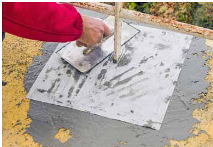
Aplikace speciální hydroizolační bandáže
