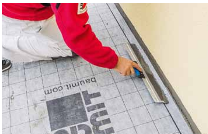
Vytlačení přebytečného vzduchu z hydroizolační membrány
