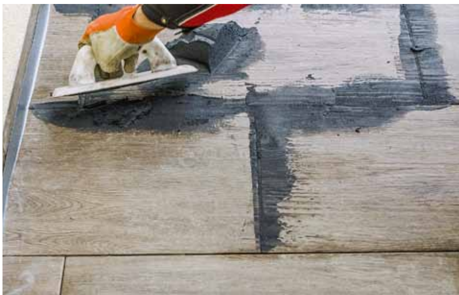
Spárování dlažby spárovací hmotou Baumit Baumacol PremiumFuge
