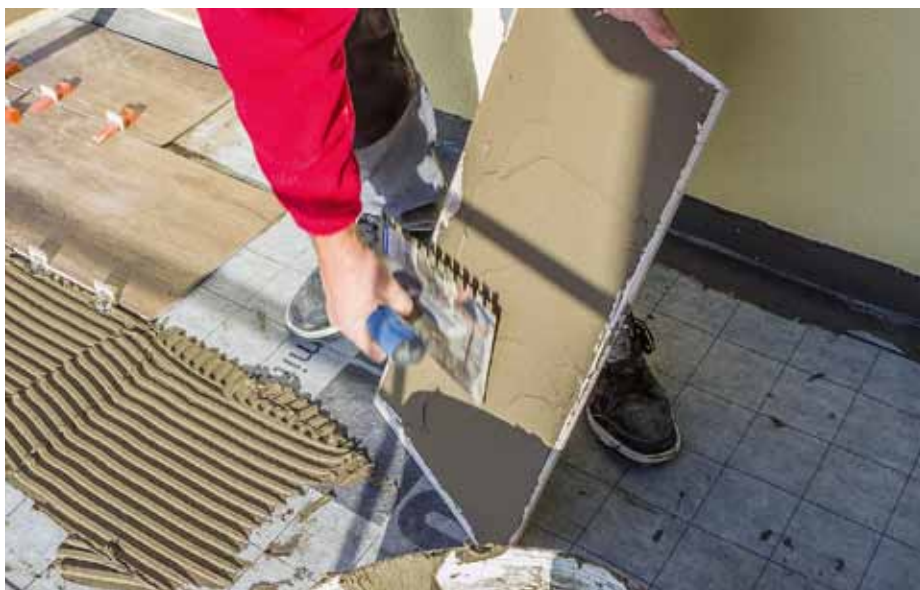
Nanášení druhé vrstvy rychletuhnoucího lepidla Baumit FlexTop Speed před finální pokládkou dlažby
