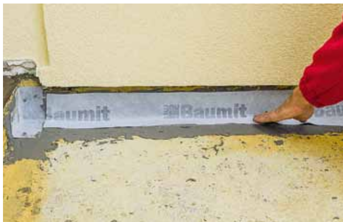
Aplikace speciální hydroizolační manžety
