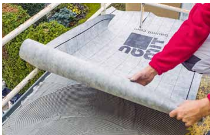
Vtlačení hydroizolační membrány do rychleschnoucího lepidla Baumit FlexTop Speed
