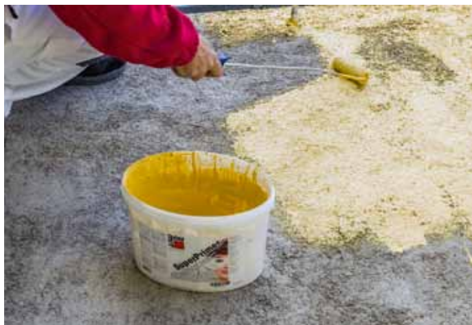
Aplikace kontaktního můstku Baumit SuperPrimer
