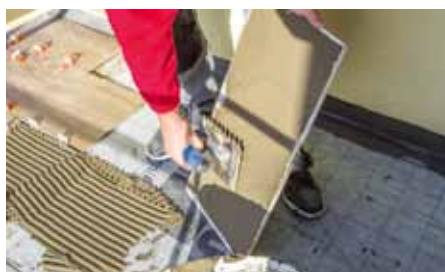
Baumit Baumacol AquaSafe, realizace – nanášení druhé vrstvy rychletuhnoucího lepidla Baumit FlexTop Speed před finální pokládkou dlažby
