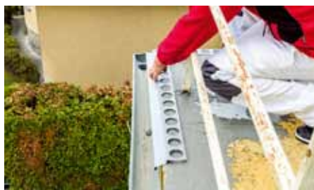
Baumit Baumacol AquaSafe, realizace – montáž okapnice
