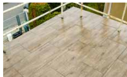
Baumit Baumacol AquaSafe, realizace – finální pohled
