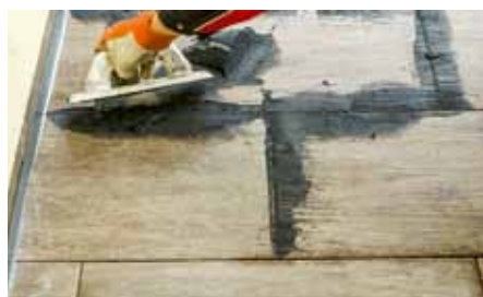
Baumit Baumacol AquaSafe, realizace – spárování dlažby spárovací hmotou Baumit Baumacol PremiumFuge
