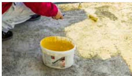
Baumit Baumacol AquaSafe, realizace – aplikace kontaktního můstku Baumit SuperPrimer
