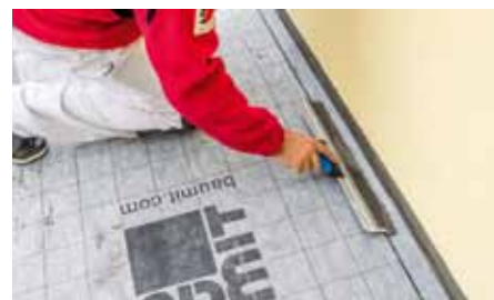
Baumit Baumacol AquaSafe, realizace – vytlačení přebytečného vzduchu z hydroizolační membrány
