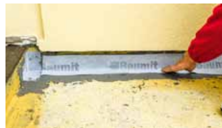
Baumit Baumacol AquaSafe, realizace – aplikace speciální hydroizolační manžety
