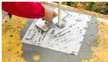
Baumit Baumacol AquaSafe, realizace – aplikace speciální hydroizolační bandáže
