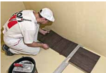
Dlaždice se pokládá na zazubenou plochu a přitlačí se. Postupně se osazuje dlažba po celé ploše s použitím obkladačských křížků, popř. klínek pro zajištění stejné tloušťky spár. U styku stěn je nutné dodržet dostatečné šířky dilatačních spár.
