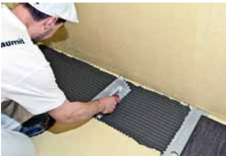
Po vyvržení hydroizolačního souvrství (cca 24 hod.) je možné lepit obkladové prvky – vždy je nutné vybrat vhodný typ lepidla, který je odvislý od celého spektra požadavků. Pro čistě interiérové lepení je možné použít lepicí hmotu Baumit Baumacol Basic. Lepicí maltu je nutné nanášet na podklad ve 2 pracovních krocích. V prvním pracovním kroku nanést tenkou kontaktní vrstvu. Na ještě mokrou vrstvu nanést ve druhém pracovním kroku ozubenou stěrku odpovídající vrstvu lepicí hmoty pod úhlem 45–60°.
