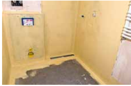
Hydroizolační nátěr Baumit Baumacol Proof je nutné provádět vždy ve dvou vrstvách, minimální tloušťka jedné vrstvy je 1 mm. Mezi vrstvami je nutné dodržet potřebný čas k odvětrání, cca 4 hodiny.
