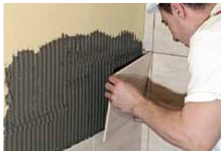
Dlaždice se pokládá na zazubenou plochu a přitlačí se. Postupně se osazuje dlažba po celé ploše s použitím obkladačských křížků, popř. klínek pro zajištění stejné tloušťky spár. U styku stěn je nutné dodržet dostatečné šířky dilatačních spár.
