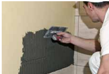
Po vyvržení hydroizolačního souvrství (cca 24 hod.) je možné lepit obkladové prvky – vždy je nutné vybrat vhodný typ lepidla, který je odvislý od celého spektra požadavků. Pro čistě interiérové lepení je možné použít lepicí hmotu Baumit Baumacol Basic. Lepicí maltu je nutné nanášet na podklad ve 2 pracovních krocích. V prvním pracovním kroku nanést tenkou kontaktní vrstvu. Na ještě mokrou vrstvu nanést ve druhém pracovním kroku ozubenou stěrku odpovídající vrstvu lepicí hmoty pod úhlem 45–60°.
