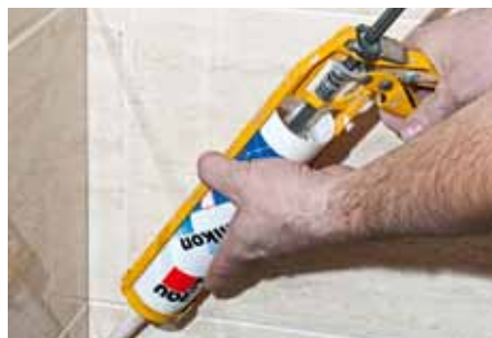
Veškeré namáhané spoje (např. styk podlah a stěn, dilatační spáry) se vyplní pružným silikonovým tmelem Baumit Baumacol Silikon. Před aplikací tmelu je doporučeno do spáry vložit těsnící provazec, který zajistí pnutí hmoty ve spáře v jednom směru a zajišťuje tím dlouhodobou životnost spárovacího tmelu.
