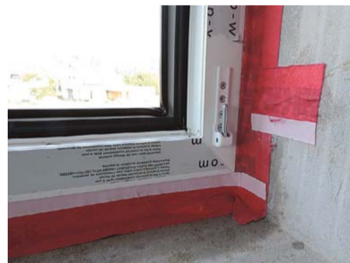
Správné zalepení rohu okna ochrannými fóliemi
