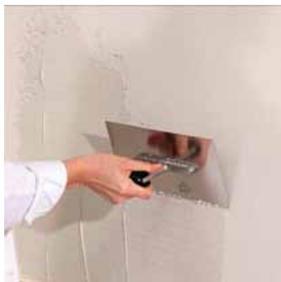
Baumit CreativTop – nanášení omítky
