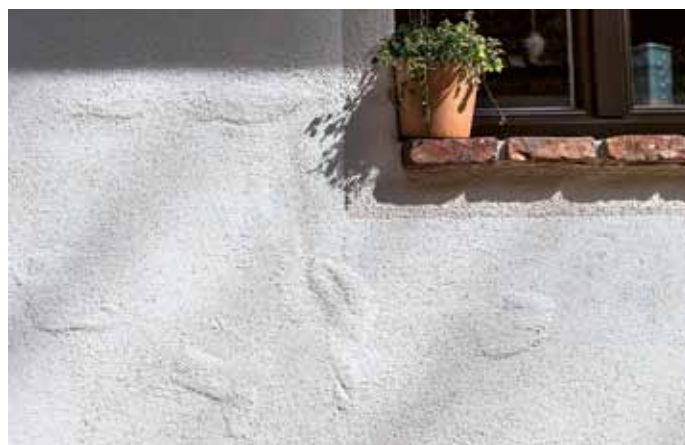
Technika zatírání štětkou
