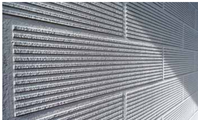
Technika strukturování zubým hladítkem
