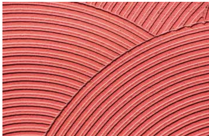
Technika strukturování zubým hladítkem
