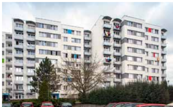
Panelový dům, Tábor, povrchová úprava Baumit NanoporTop
