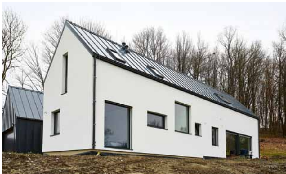
Rodinný dům, Pulečný – zateplovací systém Baumit, povrchová úprava Baumit NanoporTop
