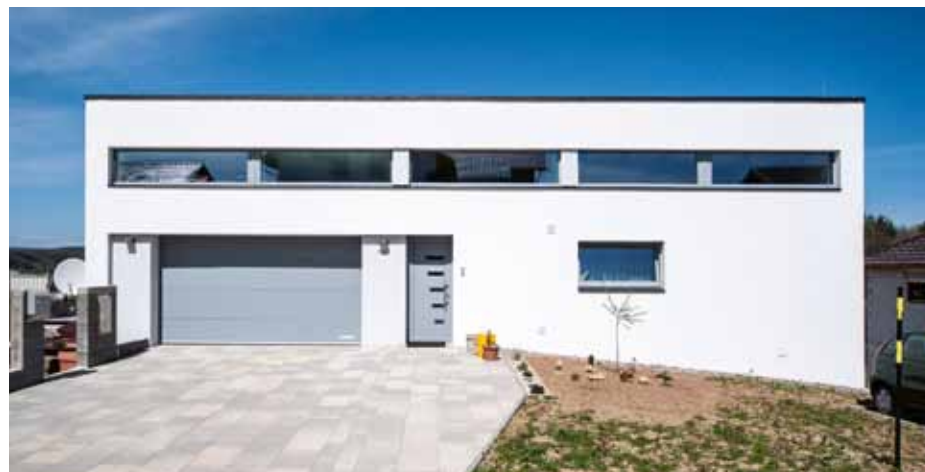
Rodinný dům, Lípa nad Dřevnicí – zateplovací systém Baumit, omítka Baumit NanoporTop
