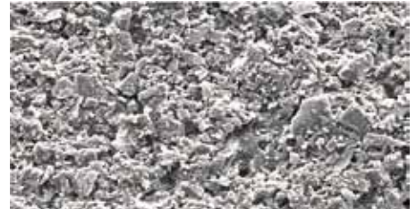
Povrch tradiční omítky je výrazně hrubší a špína na něm ulpí snadněji
