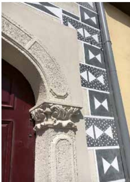
Renovace Panského domu Svätý Jur, Slovensko
