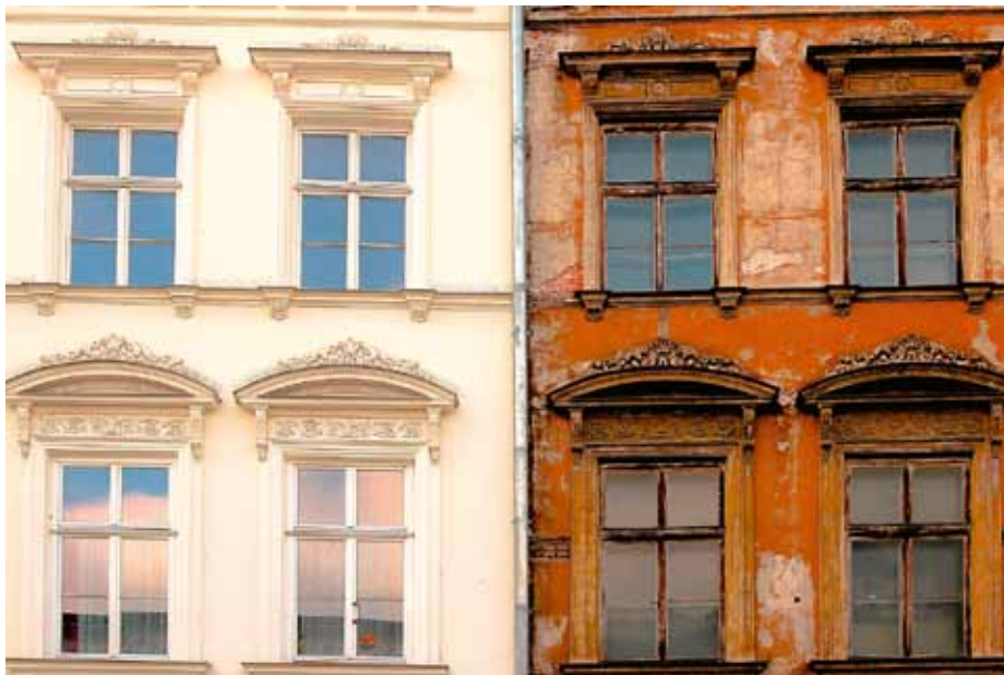
Baumit WTA – sanace omítky domu
