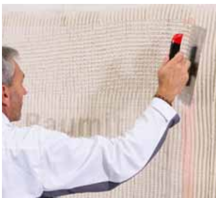
Přestěrkování fasády renovační stěrkou Baumit MultiWhite pomocí zubového hladítka
