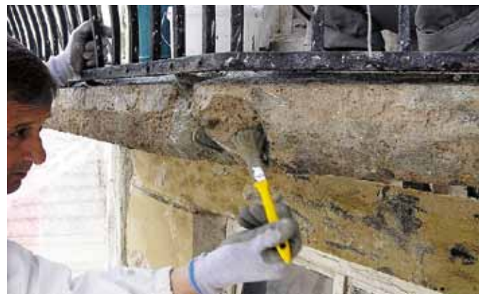
Aplikace nátěru Baumit BetoProtect
