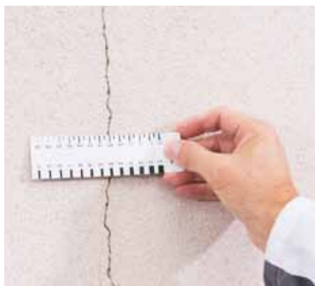
Kontrola fasády, ověření šířky trhliny pomocí kalibrovaného přípravku
