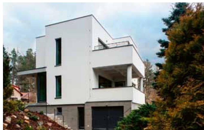
Výstavba rodinného domu, Stříbrná Skalice
