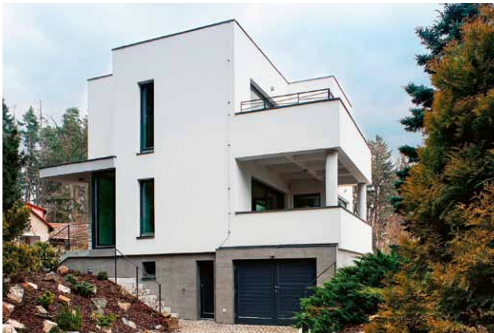
Rekonstrukce rodinného domu ve Stříbrné Skalici
