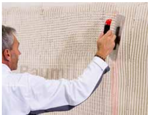
Přestěrkování fasády renovační stěrkou Baumit MultiWhite pomocí zubového hladítka
