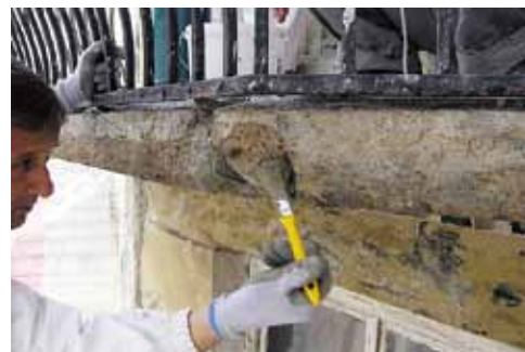
Aplikace antikoroziního nátěru Baumit BetoProtect, detail opravy konstrukce
