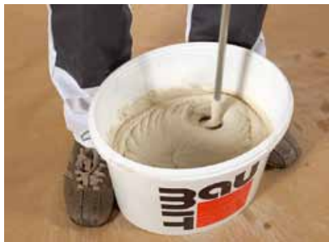
Promíchání renovační stěrky Baumit MultiWhite ručním elektrickým míchadlem
