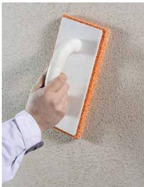
Zahřazení druhé vrstvy stěrky Baumit MultiWhite pomocí pěnového hladítka
