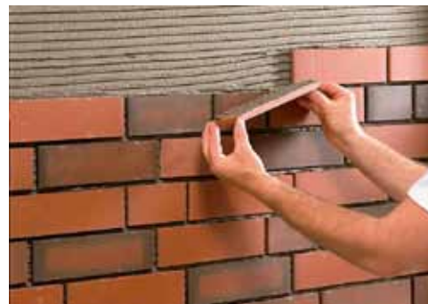
Baunit Ceramic – montáž obkladu
