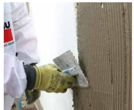
Nanášení stěrkové hmoty Baumit StarContact pro vytvoření výztužné vrstvy
