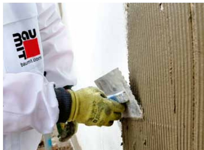
Nanášení stěrkové hmoty Baumit StarContact pro vytvoření výztužné vrstvy
