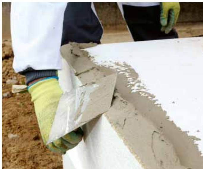
Nanášení lepicí hmoty Baumit StarContact
