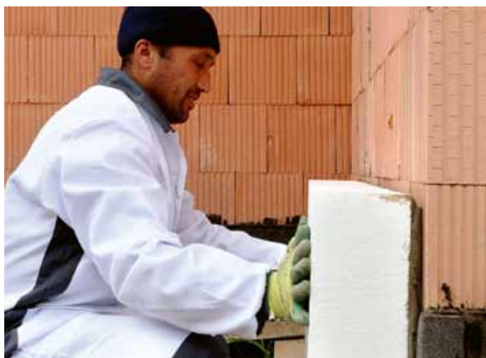
Lepení tepelněizolačních desek z EPS-F
