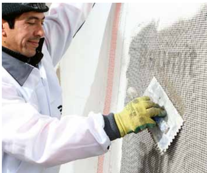
Vytváření výztužné vrstvy vložení sklotextilní síťoviny Baumit KeraTex
