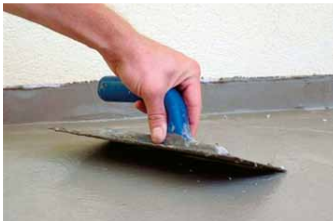
Pokládka hydroizolační stěrky
