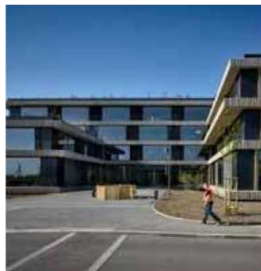
↑ Centrála ČSOB - SHQ, Praha Nová centrála této banky nabízí svým zaměstnancům nebývalý komfort v podobě několika úrovní zelených střešních přístupných přímo z kanceláří.
