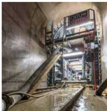
↑ Stavba č. 8615 Kolektor Hlávčův most, Praha Další z nepříliš efektních, ale o to důležitějších staveb. Přestože na povrchu o ní běžní lidé vůbec nemusí vědět.
