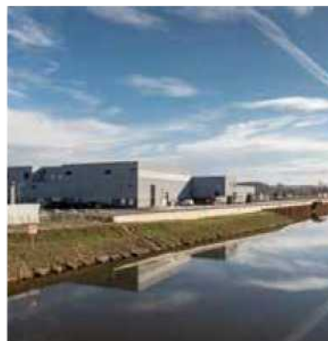
↑ Celková přestavba ÚČOV Praha na Císařském ostrově, Praha Rozsáhlá a lapidárně řešená přestavba největší čistírny odpadních vod v Praze zajistí lepší kvalitu vody ve Vltavě i budoucím generacím.
